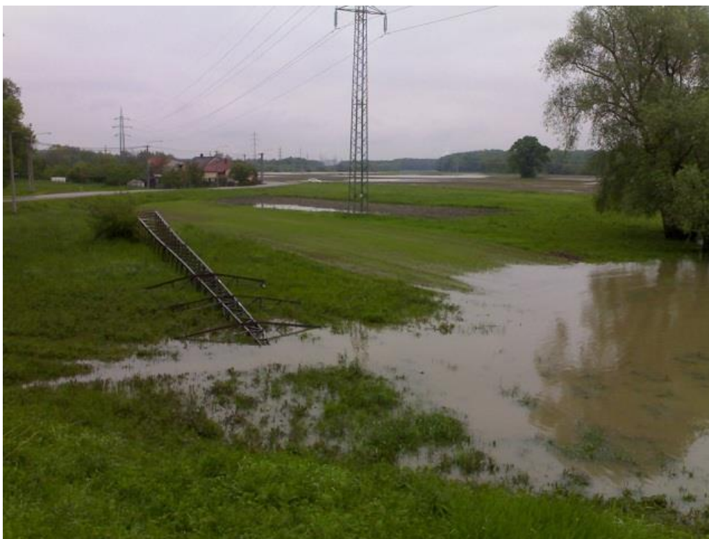
Obrázek 5. Vyvrácený stožár po zaplavení řekou Odrou [vlastní zdroj]
